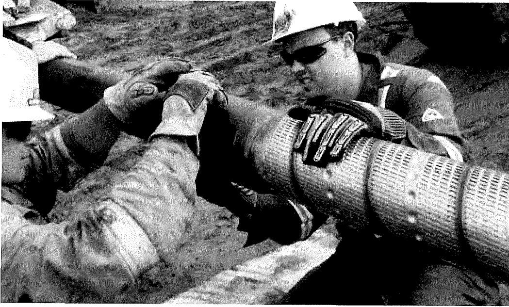
下图是膨胀式封隔器，遇油水后自动膨胀，将油水一段一段分割开，避免相互串通影响。
